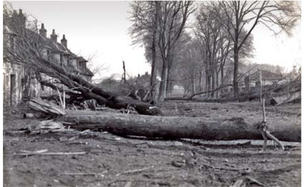
7. Endommagement des voies de communication lors du repli allemand, mars 1917
